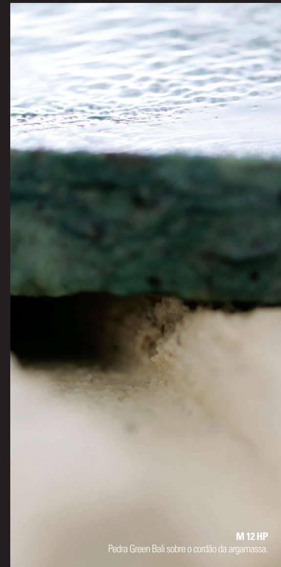
M 29 HP Cordões da argamassa fluida.
