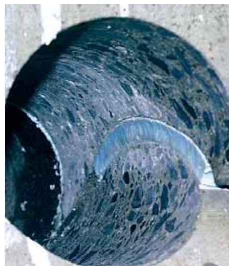
Junta de construção injetada
