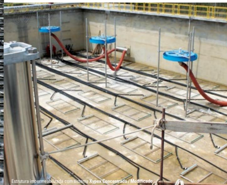
Estrutura impermeabilizada com sistema Xypex Concentrado / Modificado
