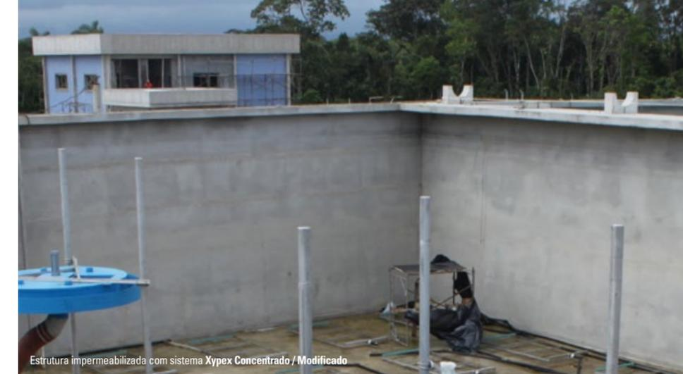
Estrutura impermeabilizada com sistema Xypex Concentrado / Modificado
