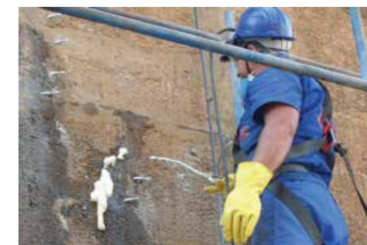
Aplicação do MC-Injekt 2033
