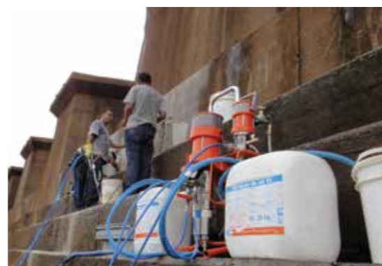
Aplicação do MC-Injekt GL-95 TX
