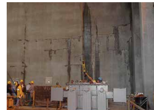
Problemas usuais de infiltração em casa de forças
