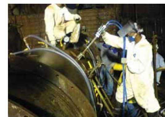
Aplicação do MC-Injekt 2700 L
