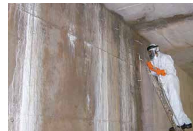
Aplicação do MC-Injekt 1264 compact
