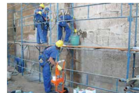
Aplicação do MC-Injekt 2300 flow
