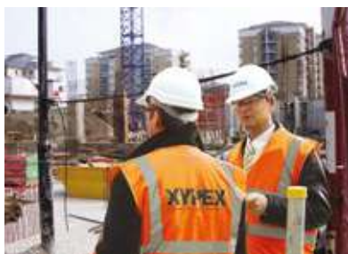
▶ SUPORTE EM OBRA
