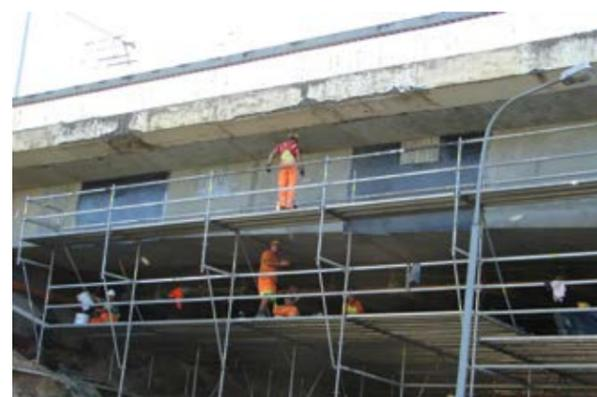
Aplicação da manta de fibra de carbono MC-CarbonFiber Sheets
