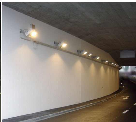
Túnel com a Pintura MC-Color T21
