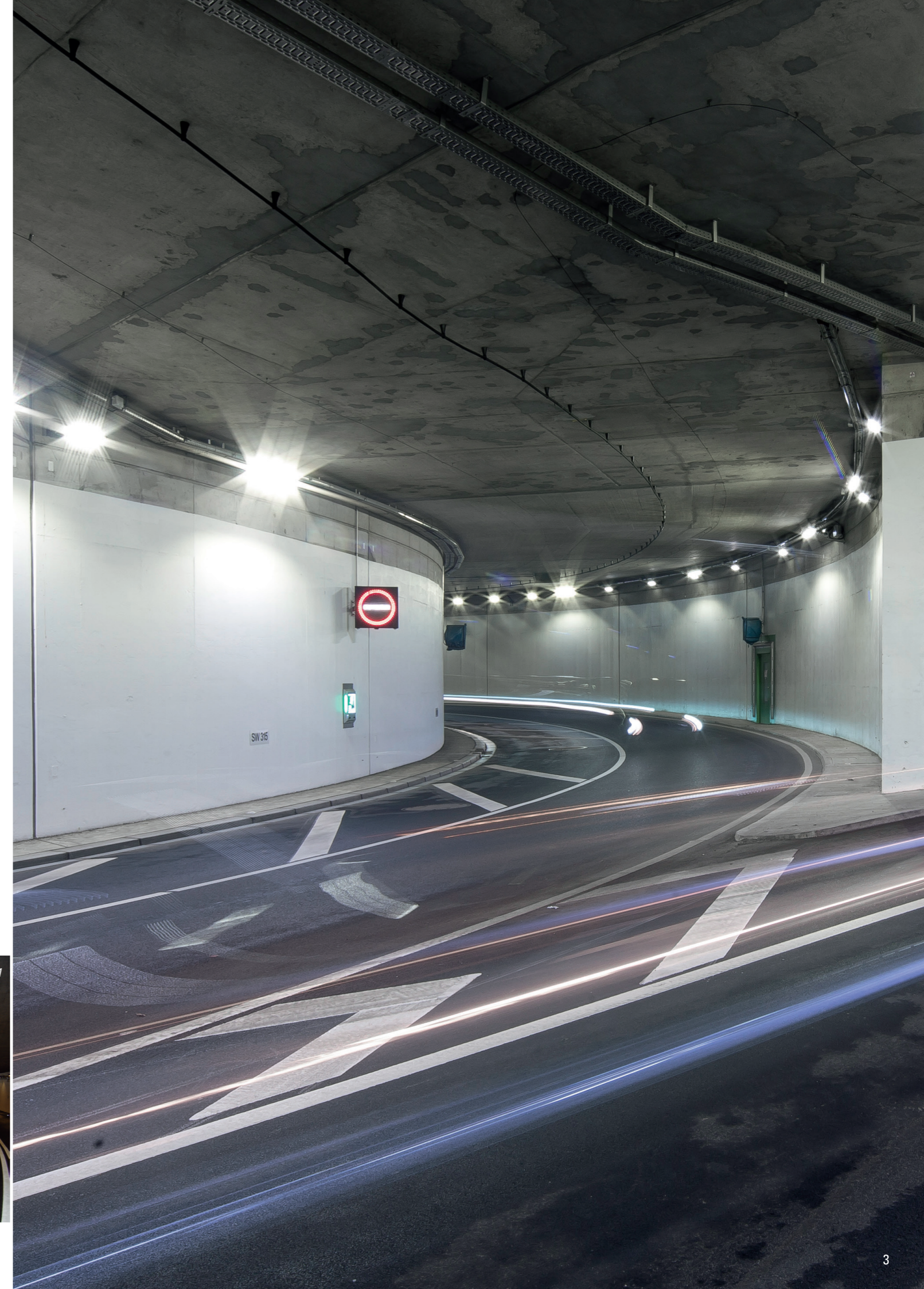
Túnel com a Pintura MC-Color T21
