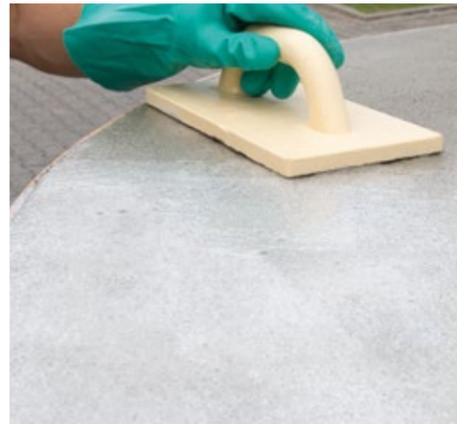
Usando um nivelador para trabalhar o acabamento do MC-DUR 1177WV-A na superfície
