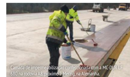
Camada de impermeabilização confeccionada com a MC-DUR LF 680 na rodovia A8, próximo a Merzig, na Alemanha.
